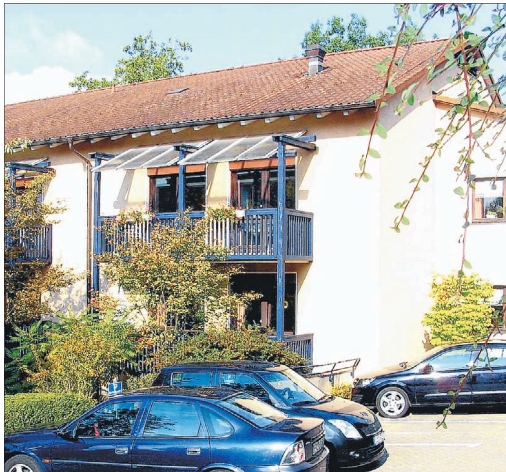
Im Oktober soll das Hospiz am Buck seine Räume im Paulushaus in Stetten beziehen.
