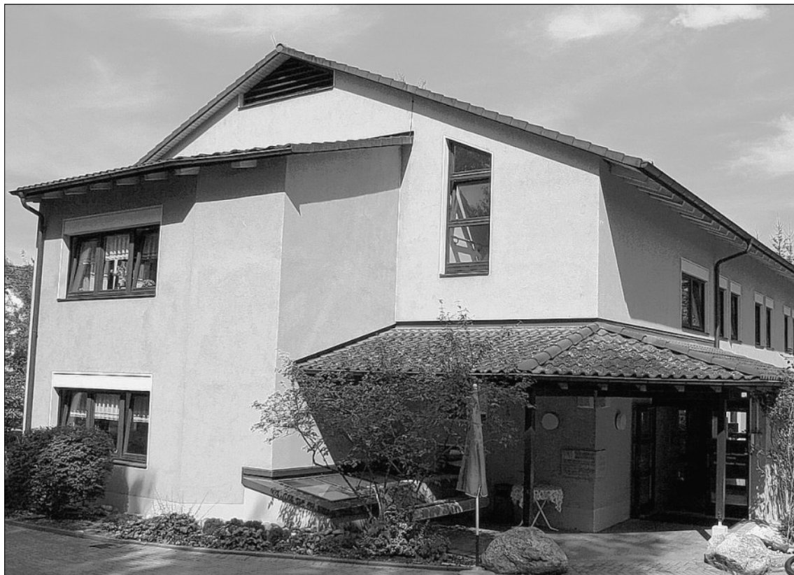
Im Ober- und Untergeschoss des Paulusbaus, dem Nebengebäude des Pflegeheims St. Fridolin in Lörrach-Stetten, wird das stationäre Hospiz sein Domizil haben. Foto: Michaela Wassmer
